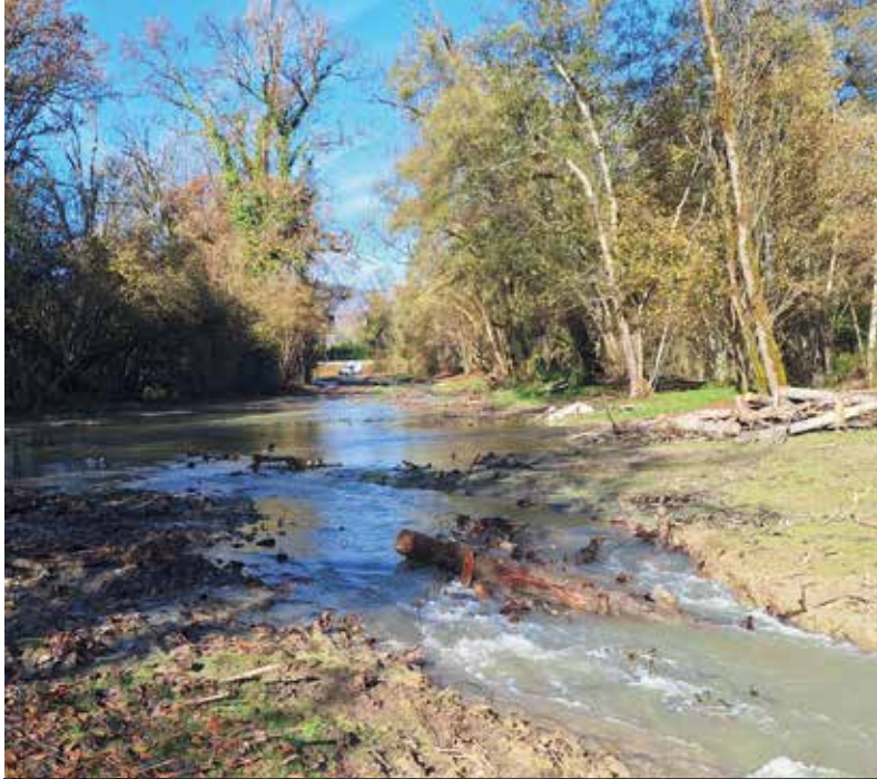
Restauration de la Deysse (Entrelacs)
