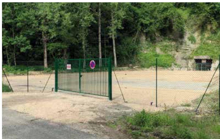
Création d'une plateforme d'accès à la descenderie de la galerie
