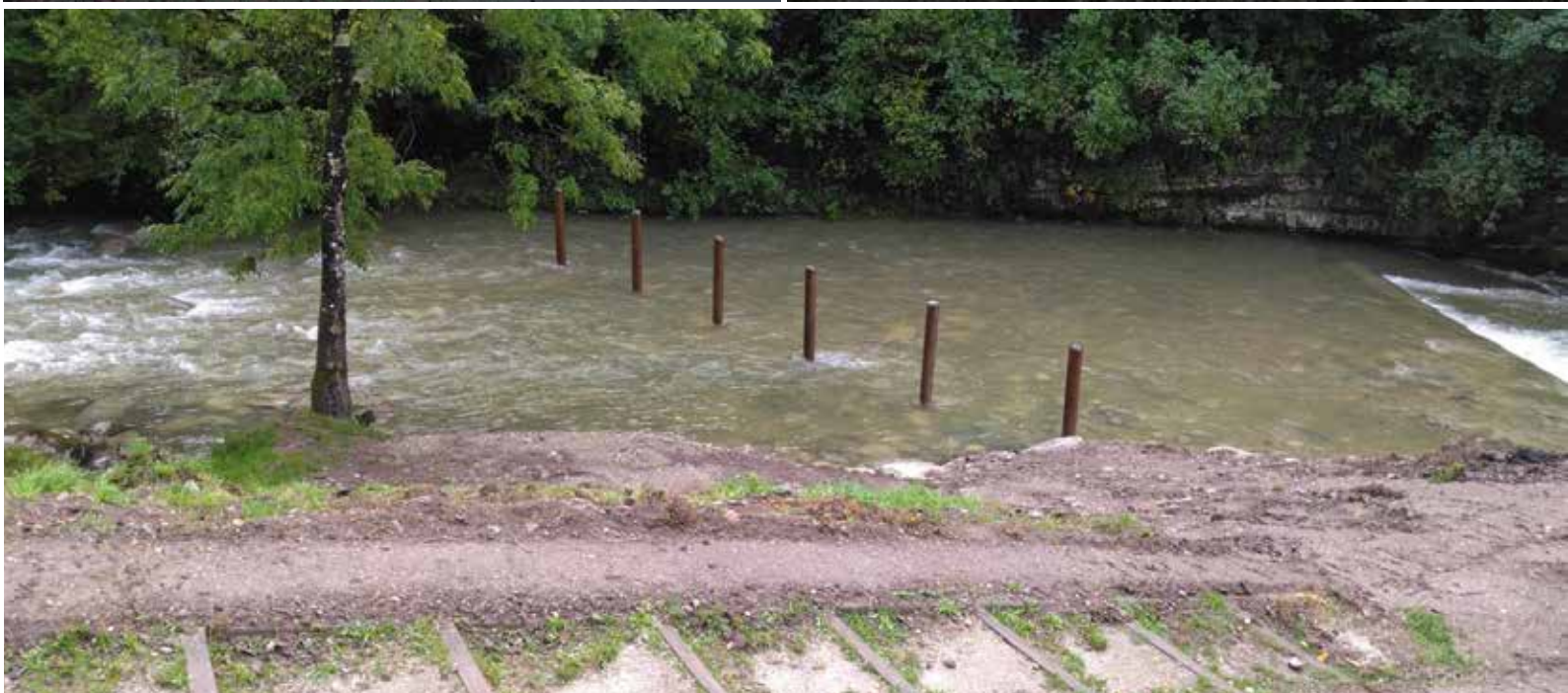
Création d'un tri bois sur la Leyse au Bout du Monde (St-Alban-Leyse)
