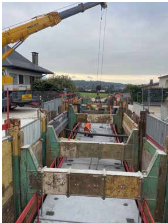
Mise en place des éléments du dalot sur le Nant Petchi
