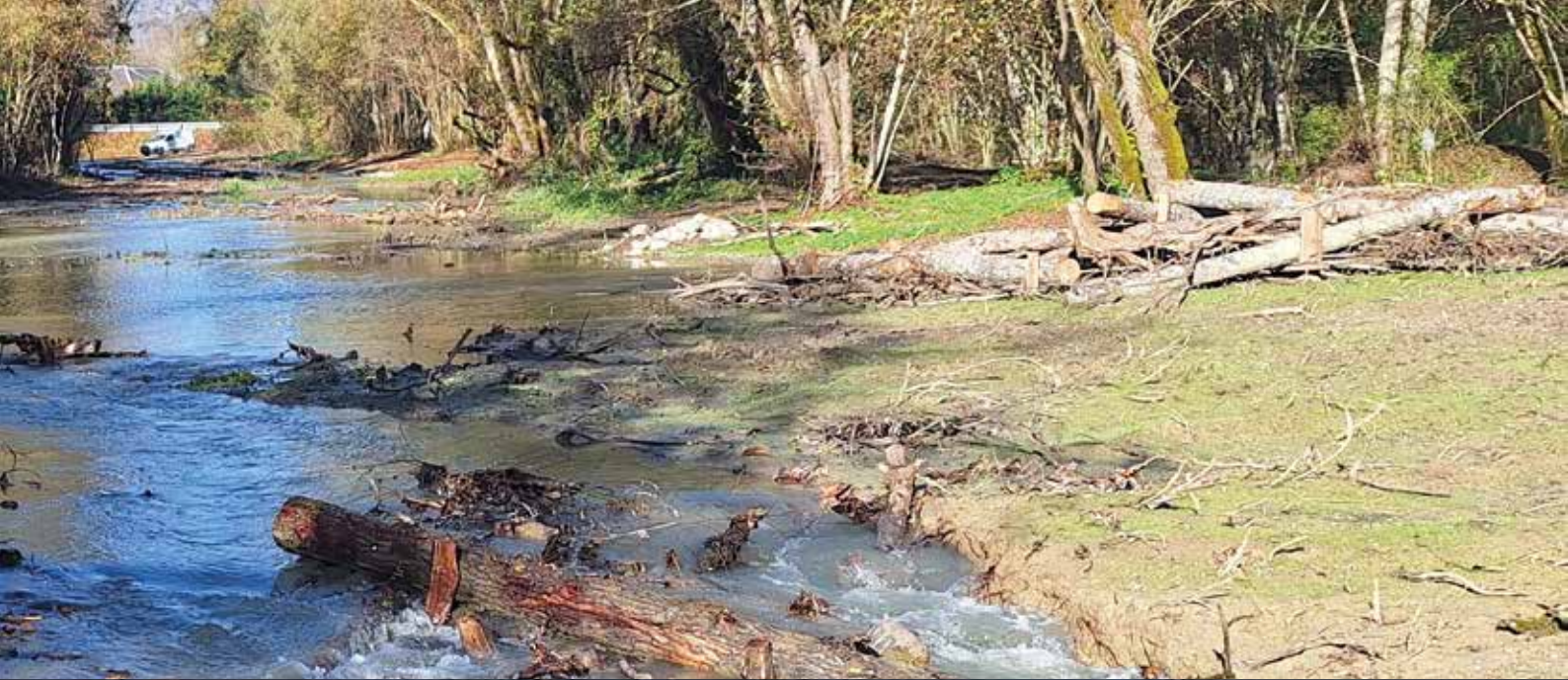
Travaux de restauration de la Deysse (Entrelacs)
