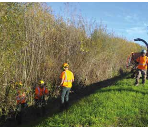
Entretien digue par la brigade bleue
