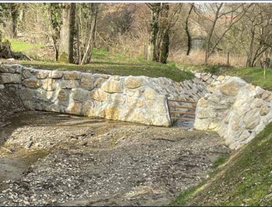
Création d'une plage de dépôt à Droise (Grésy-sur-Aix)
