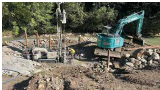
Création d'un tri bois sur la Leysse au Bout du monde
