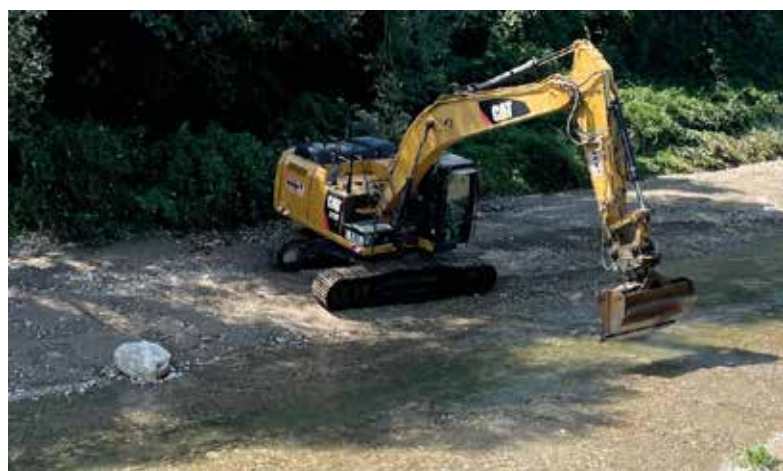
Curage de la Laysse devant les clapets du bras de décharge
